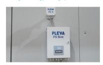
包含 PLEVA 湿度检测装置的智能节能系统能够有效减少新鲜空气供量及耗能
